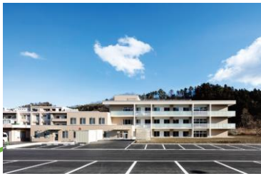
特別養護老人ホーム仙台敬寿園 仙台市青葉区下愛子田中 1-3
