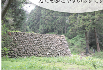
清水門跡近くにある石垣の遺構
