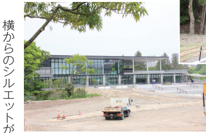
12月に開業する地下鉄東西線の国際センター駅
