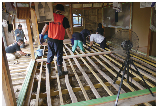
▲床板を剥がし床下の土砂撤去（大崎市古川）
