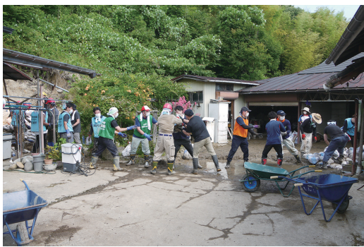
▲裏山の土砂崩れの土留のために土のうを運搬（大崎市古川）
