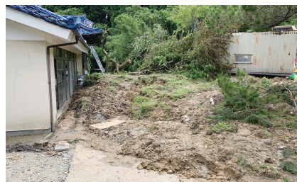
▲裏山が崩れ家屋内に流入（松島町）
