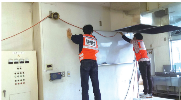
〈DWAT活動 床にある配線を頭上に上げる作業中〉
